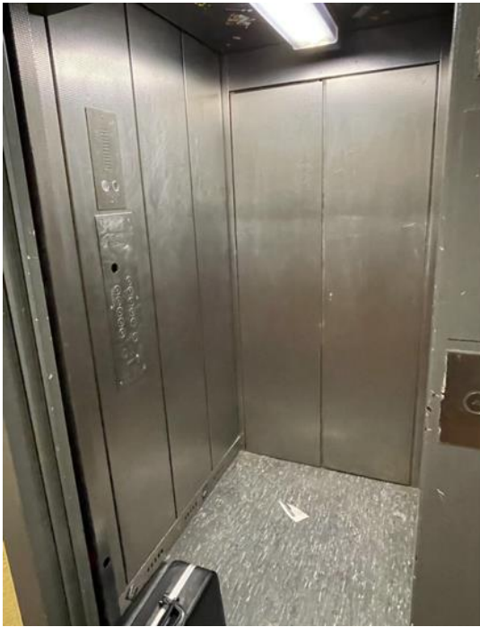
Abbildung 7–8: Kleine Fahrstühle in Hochhäusern: erhöhtes Infektionsrisiko. Berlin-Marzahn, Mai 2021, eigenes Foto
